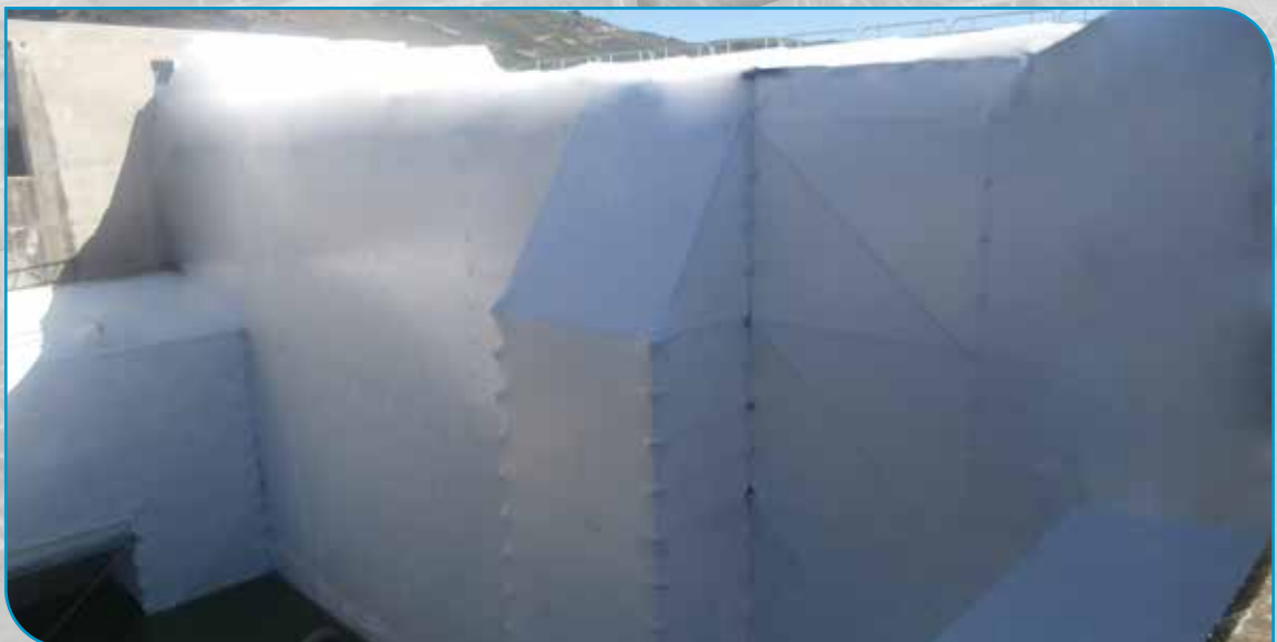
Confinement sur Barrage
