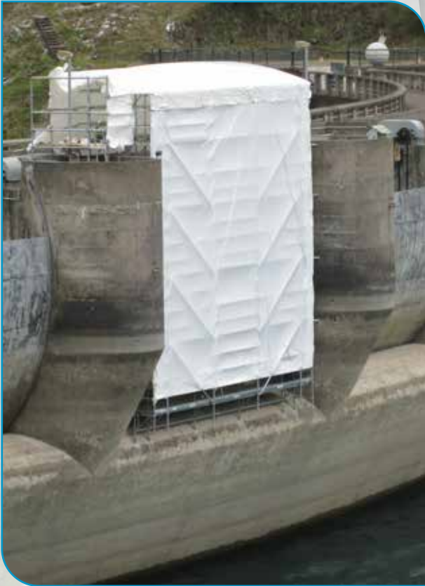
Confinement de barrage -- Avène (34)
