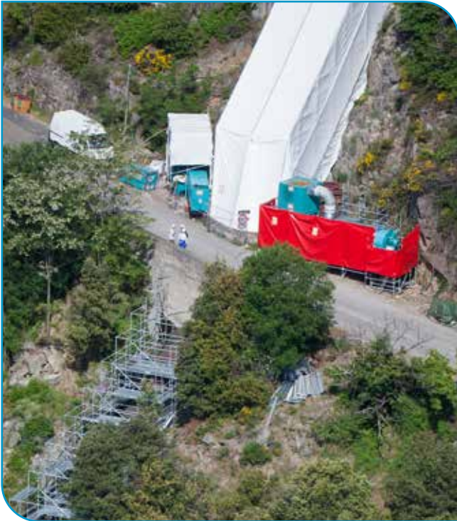
Confinement conduite forcée -- Pied de Borne (48)
