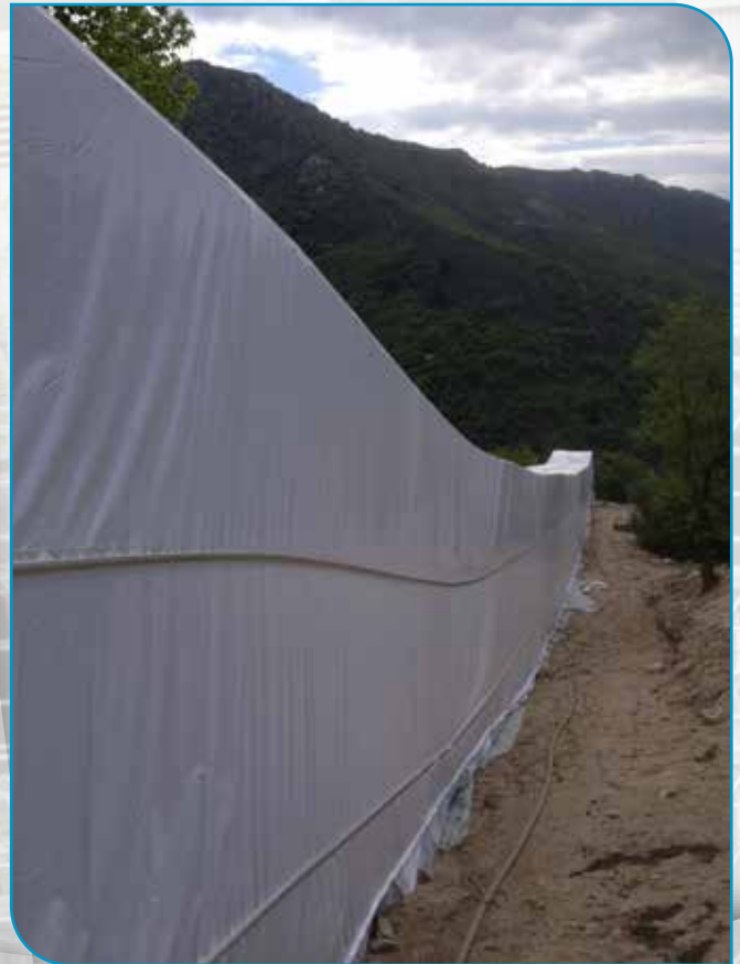
Confinement conduite forcée -- Pied de Borne (48)
